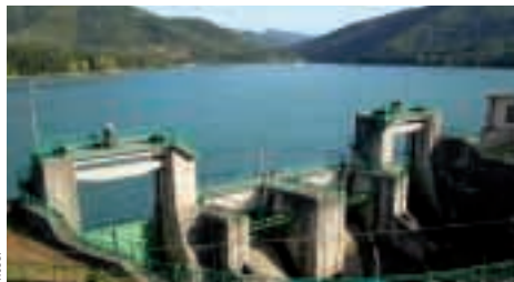
Le paratoie di fuoriuscita delle acque della diga di Suviana.
